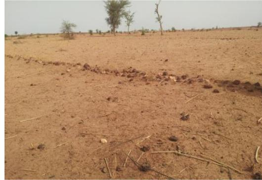
La **Banquettes** : ouvrage en terre, en pierre ou mixte sous forme de diguette antiérosive réalisée suivant les courbes de niveau. Technique adoptée au plateaux latéritique et glacis à faible pente qui permet une récupération rapide des terres. 200 000 FCFA
