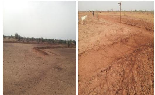
Les **Tranchées Nardi** est un micro bassins confectionnés sur des plateaux et glacis à faible pente, pour collecter les eaux de ruissellement et favoriser l'infiltration. Il permet une récupération rapide des terres en utilisant des engins (8 h de travail avec un tracteur).
