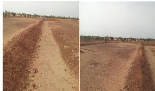
Le **seuil d'épandage** est construit en travers du lit mineur d'une vallée et perpendiculaire au sens des écoulements des eaux pour retenir les eaux de ruissellement et constituer un réservoir d'eau agro-sylvo-pastoral. Il nécessite la main d'œuvre spécialisée et a un coût élevé.
